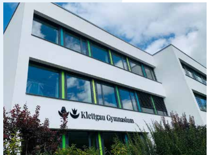
Das Klettgau-Gymnasium wurde und wird generalüberholt.
