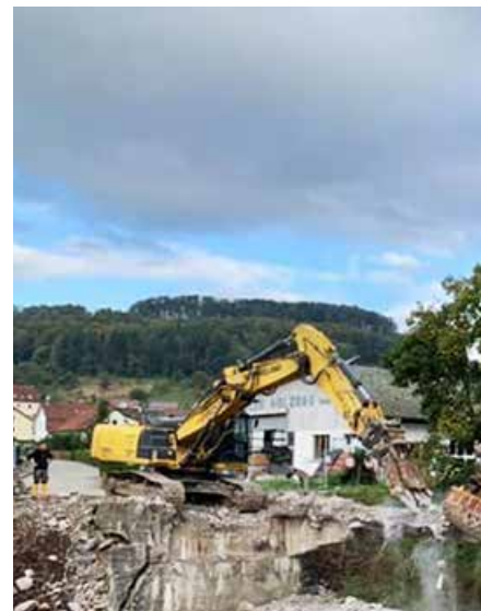
Die Schlüchtbrücke wird dieses Jahr fertig.
