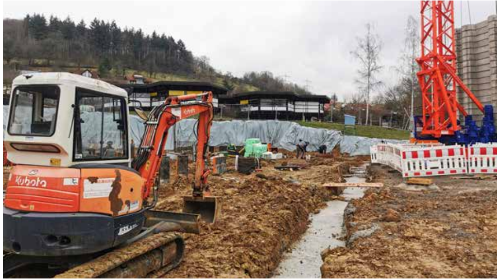
In allen neun städtischen Schulen wurde und wird um-, an- und gebaut. Wie hier der Erweiterungsbau der GWRS Gurtweil, der rund 11,3 Mio. Euro kostet. Alles für unsere Kinder. Sie sind das Kostbarste, was wir haben.
