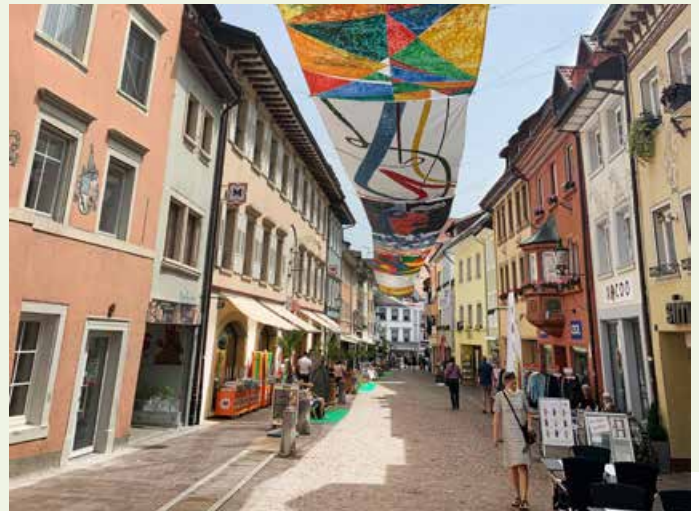
Auch in Tiengen wird saniert.
