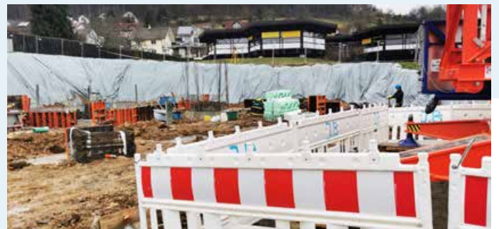
Der Erweiterungsbau der Grund- und Werkrealschule Gurtweil soll 2024 fertiggestellt sein.
