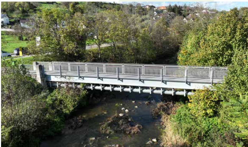
Die neue Rohrbrücke in Gurtweil ist bereits fertiggestellt.
