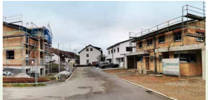
In den neuen Baugebieten wird schon fleißig gebaut.
