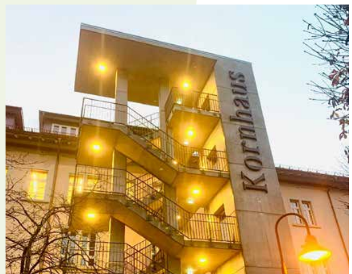
Die Sanierung des Kornhauses war das größte geförderte Einzelprojekt in Waldshut.
